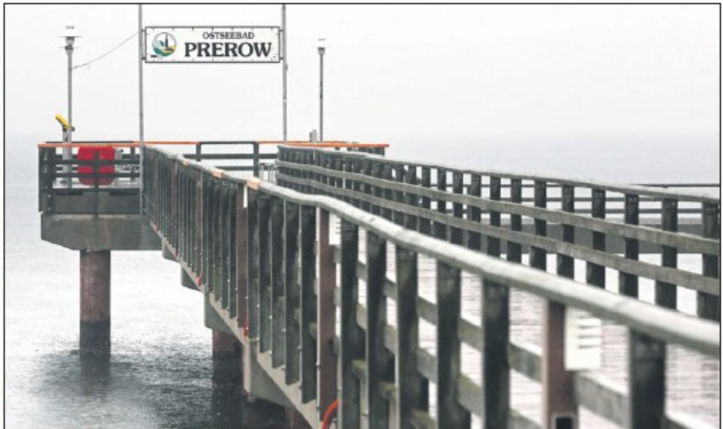
Die Prerower Seebrücke soll für den Bau des Ersatzhafens verlängert werden.
